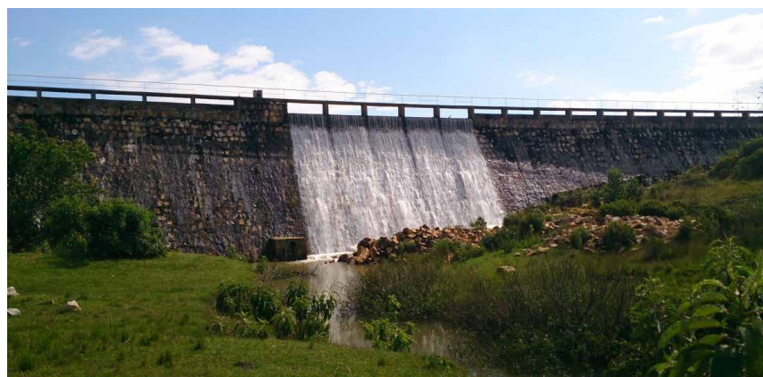
Figura 1 - Panorama da Barragem das Neves.
